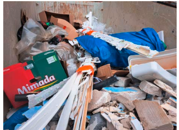
Abbildung 4 Realität auf der Baustelle © A. Wloczyk, NovaBiotec
